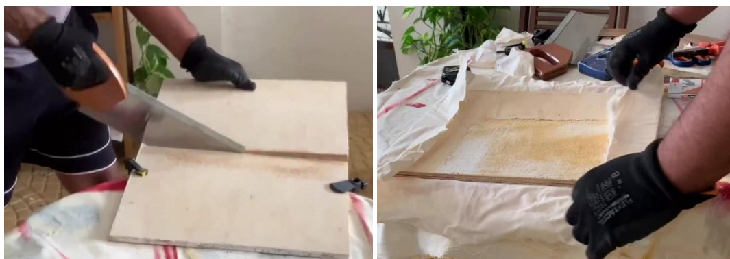
Figura 23: Corte e entelamento dos compensados de madeira. Fonte: Autor
